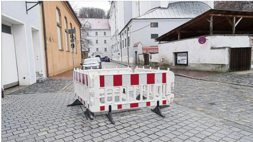
Ein Bauzaun schützt den Standort, an dem die „Mona“ im Frühjahr wieder aufgestellt werden soll.
